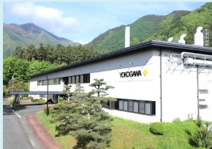
横河電機駒ヶ根工場
