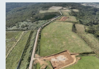
島牧・黒松内ウインドファーム建設予定地 (写真提供: コスモエコパワー(株))
