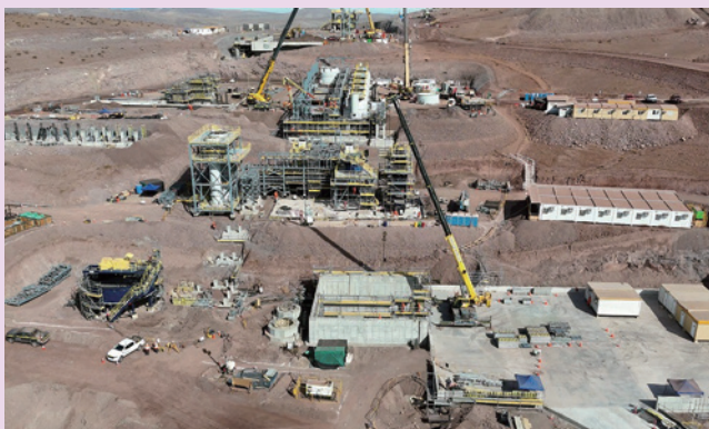
アルケロス鉱山(株)の建設中のプラント 2026年度中の商業運転開始を予定 (2025年5月撮影、写真提供:アルケロス鉱山(株))
